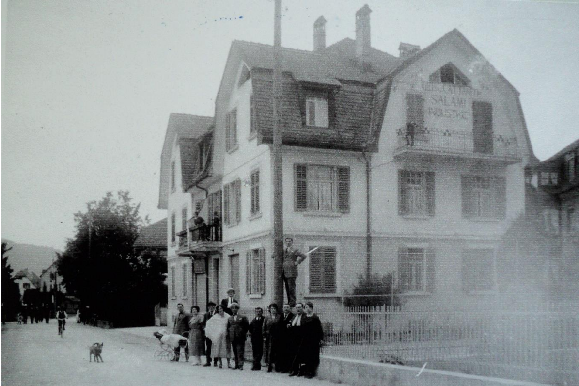
Abb. 1: Die Salamifabrik an der Weingerstrasse 29-31 (abgebrochen 1990; heute Veloparkhaus Bahnhof), um 1920.
