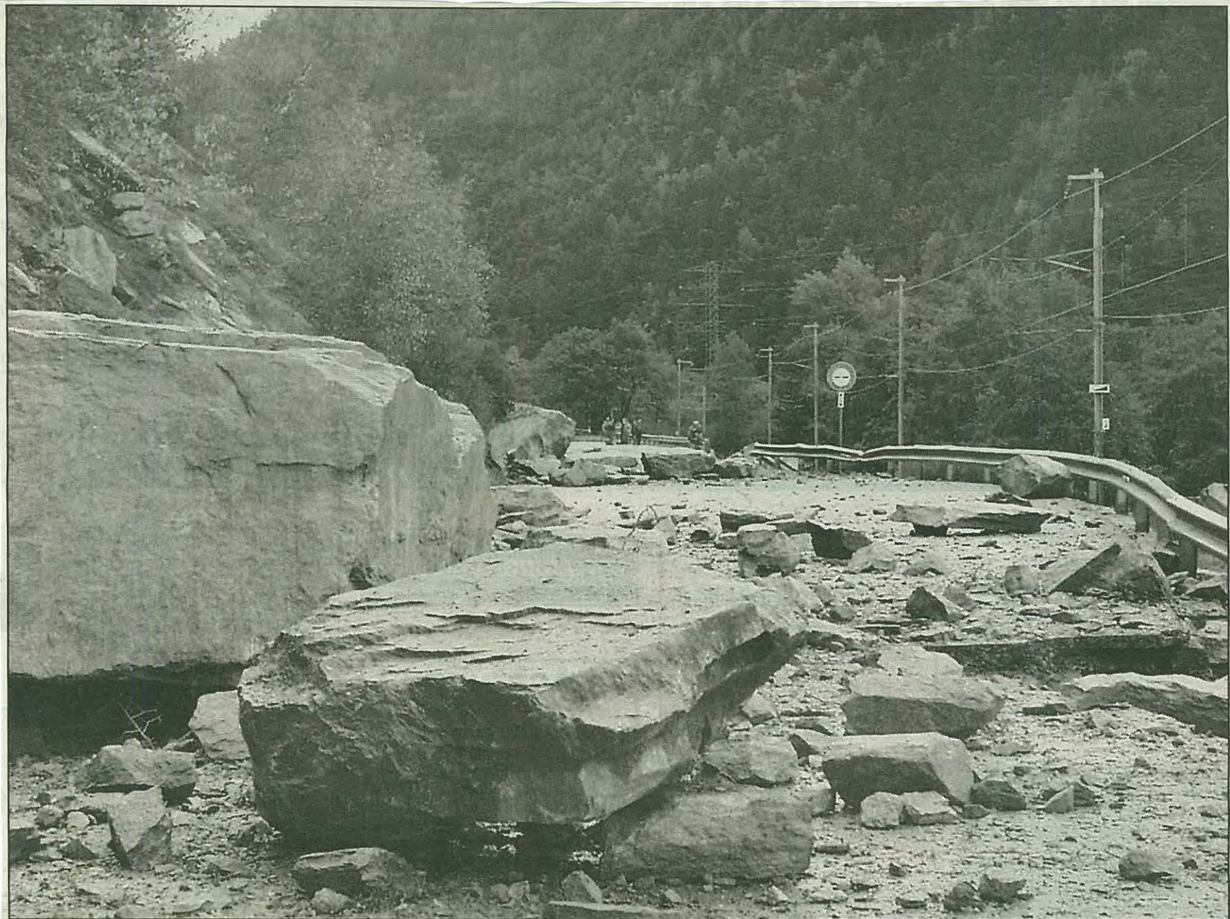
Am Sonntagmorgen verschütteten zwischen Bitsch und Mörel rund 200 Kubikmeter Gestein die Hauptstrasse sowie das Trasse der Furka-Oberalp-Bahn.
