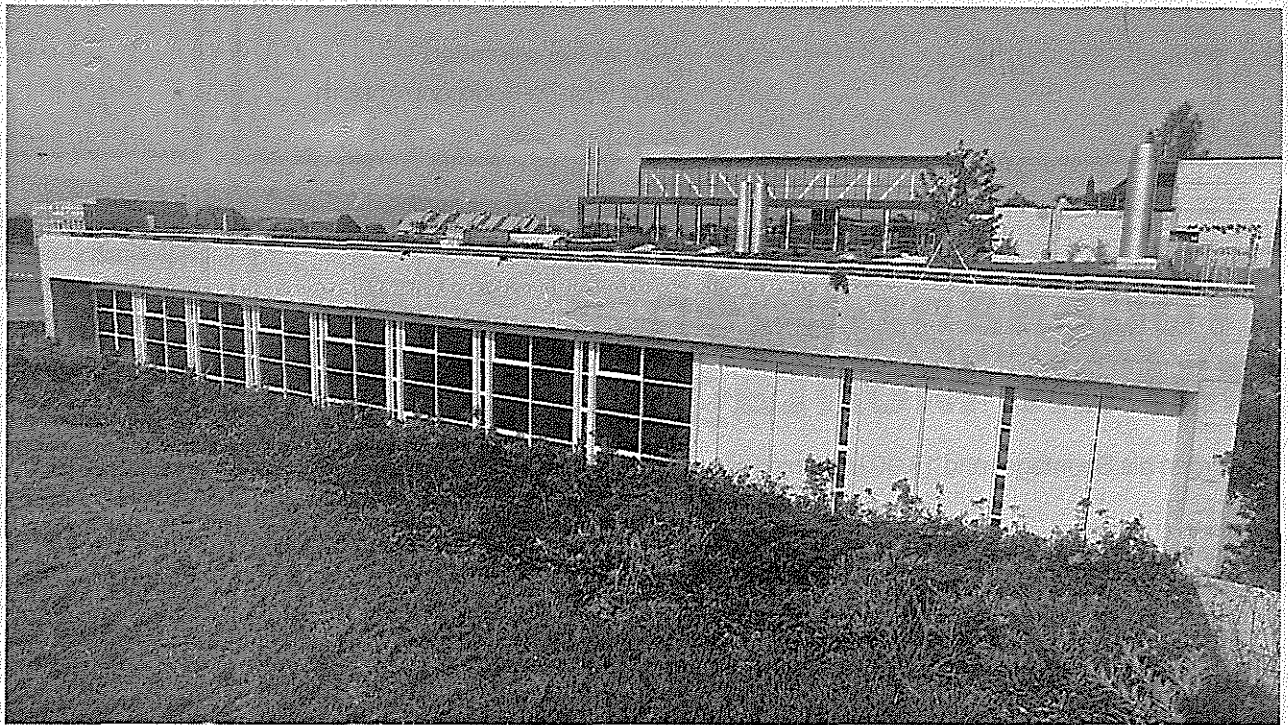
Das sehr grosse Bauvolumen der neuen Sporthalle duckt sich dank geschickter Ausnützung der Topografie unscheinbar in die Umgebung hinein. (Bilder Reto Schneider)
