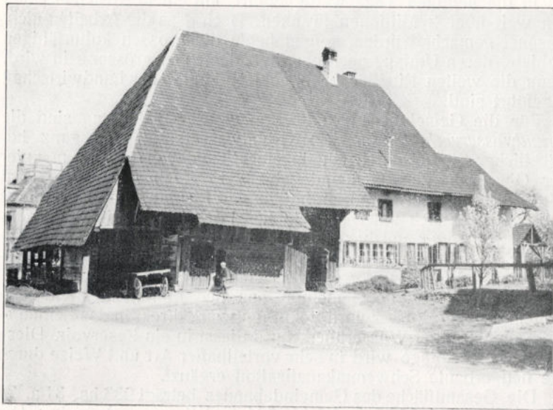
Typisches Aargauer-Haus mit ehemaliger Strohbedachung an der oberen Reppischstrasse
