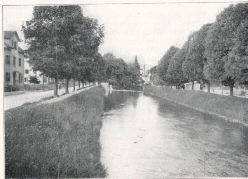
Anlage an der Reppisch
