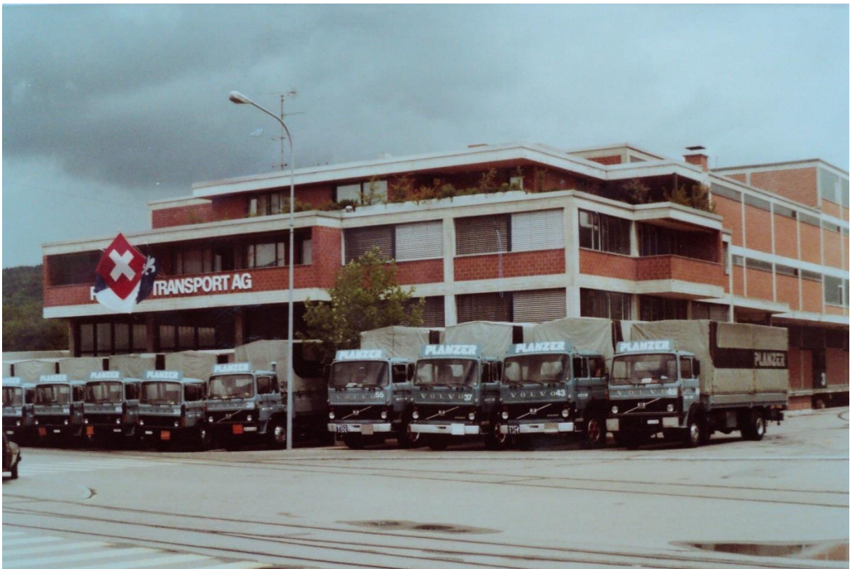
Abb. 4: Der neue Hauptsitz der «Planzer Transport AG» an der Lerzenstrasse 14, und ein Teil des Fuhrparks, 1982.
